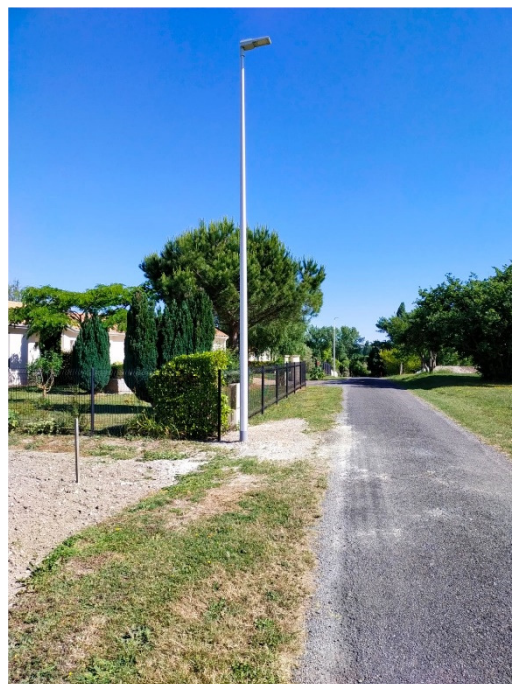
Rue des Moineries avec deux nouveaux candélabres
