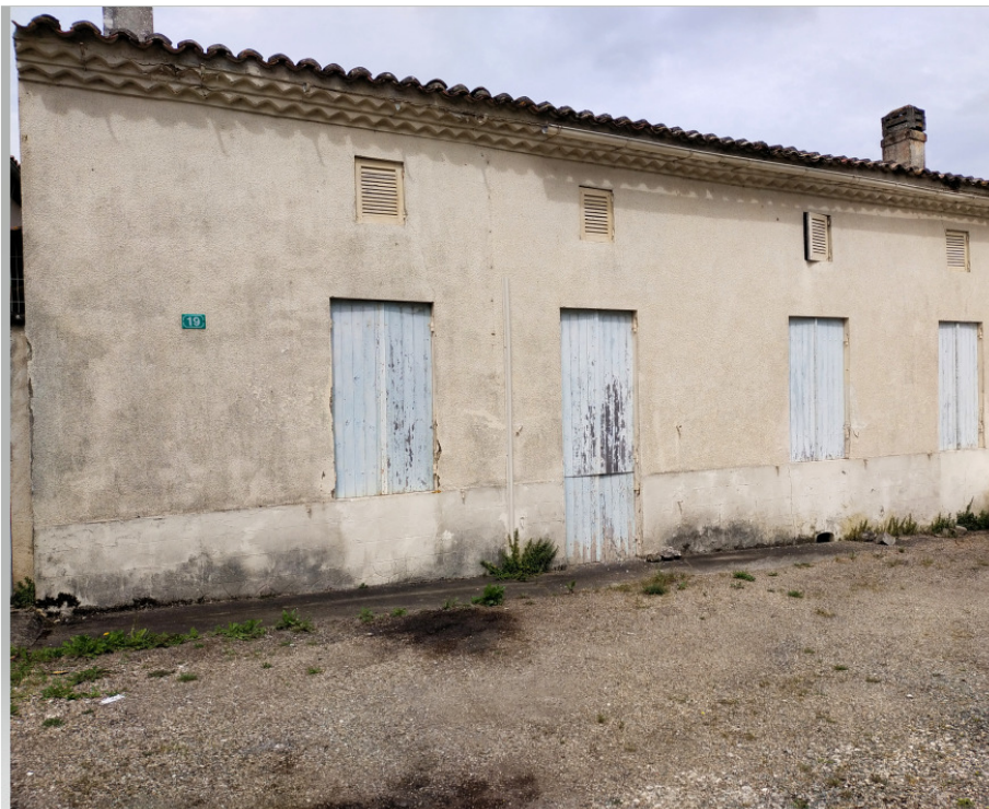
Photo actuelle de l'ancienne épicerie. Cette bâtisse est en cours d'acquisition par la commune.
